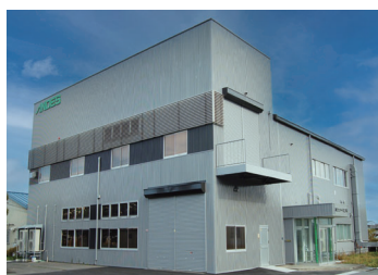
加工センター 第二工場
